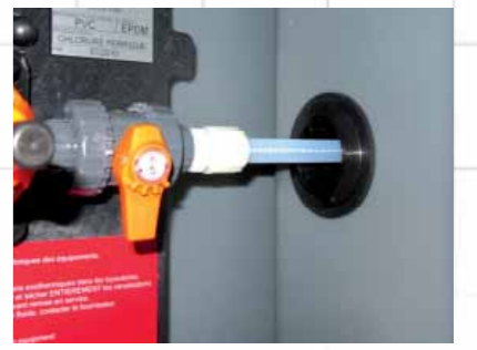
Sortie de coffret avec kit polyvalent de connexion double enveloppe
