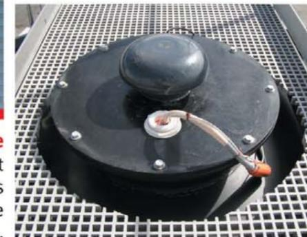
Réchauffage par thermoplongeur revêtu immergé dans le produit
