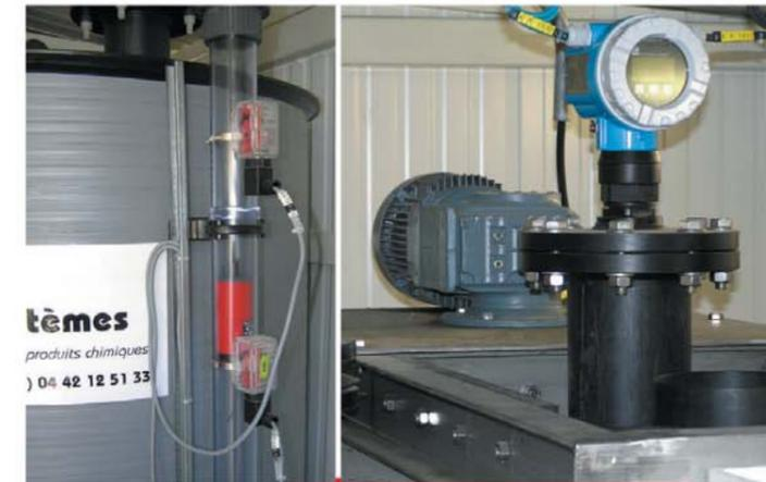
La lecture de niveau est un accessoire indispensable. Mesure par niveau à flotteur ou niveau à ondes, **Stockage & Systèmes** vous guide dans le choix de la meilleure solution technique.
