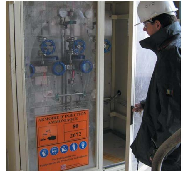
Protection assurée et mise sur rétention des équipements
