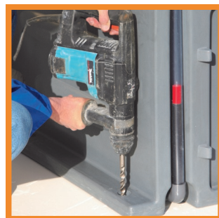
Perçage pour fixation borne au sol
