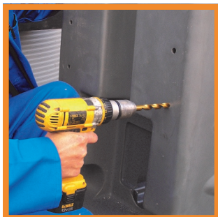
Perçage armoire pour fixation sur mur ou support
